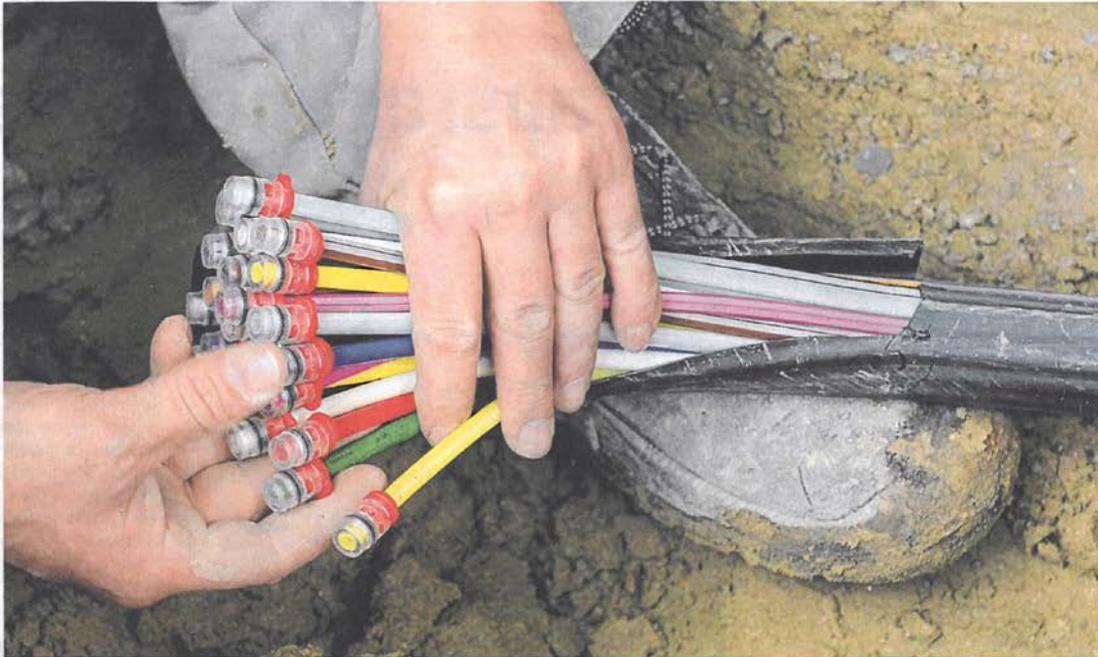
So sehen die Glasfaserkabel mit farbigen Einzelsträngen aus. BILD: DPA
